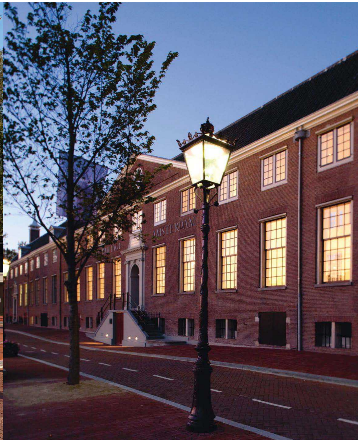
Pour l'éclairage des canaux d'Amsterdam et de la vieille ville historique adjacente, Selux a reproduit d'anciennes lanternes en intégrant une technologie LED efficace. Dans ces luminaires, un réflecteur secondaire doré à facettes avec une répartition asymétrique de la lumière assure un éclairage sans éblouissement, dans une teinte chaude apaisante.
